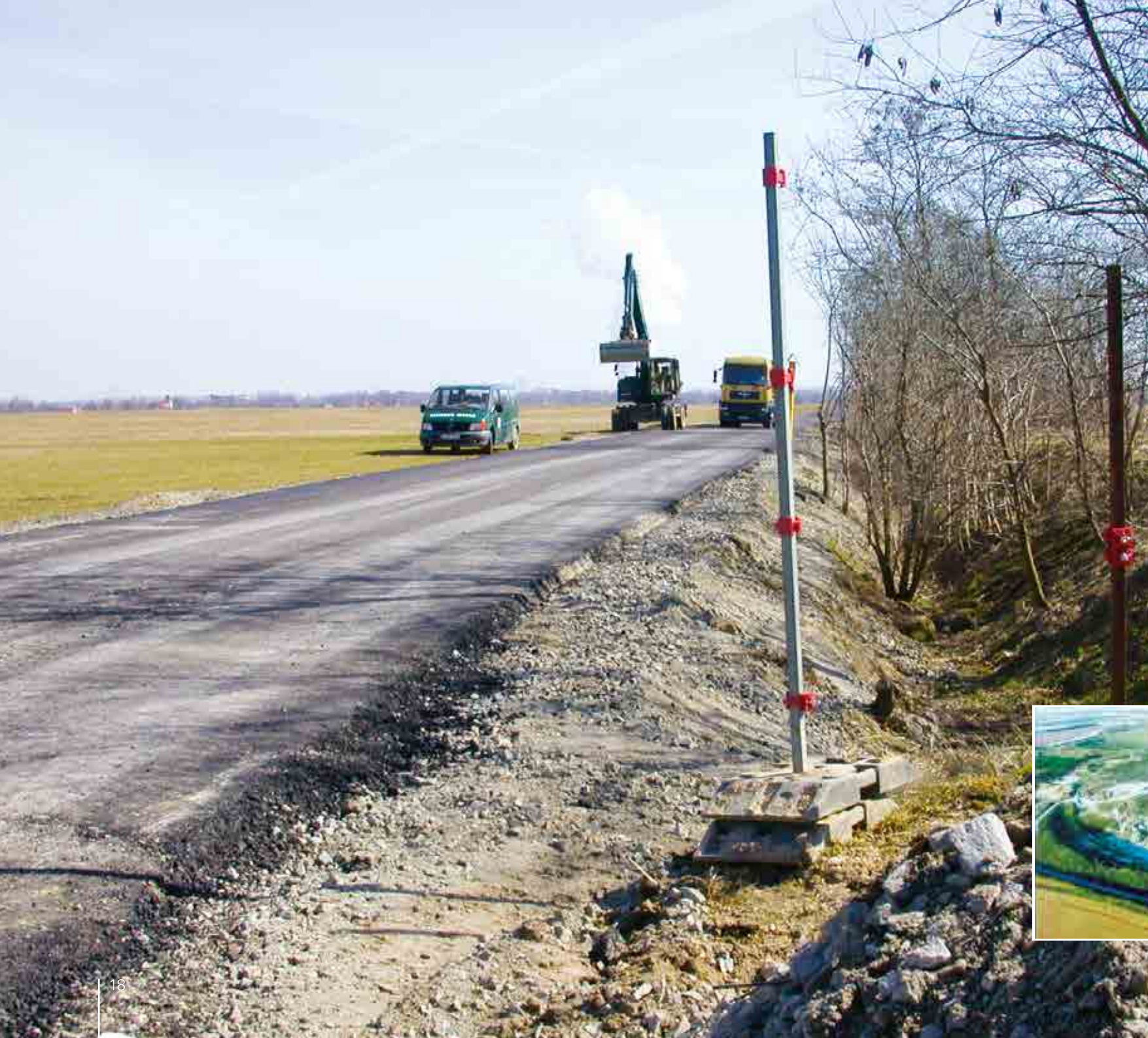
Wegebau im Bereich des Zauschwitzter Weges auf der Altkippe Profen westlich von Pegau, 2010
