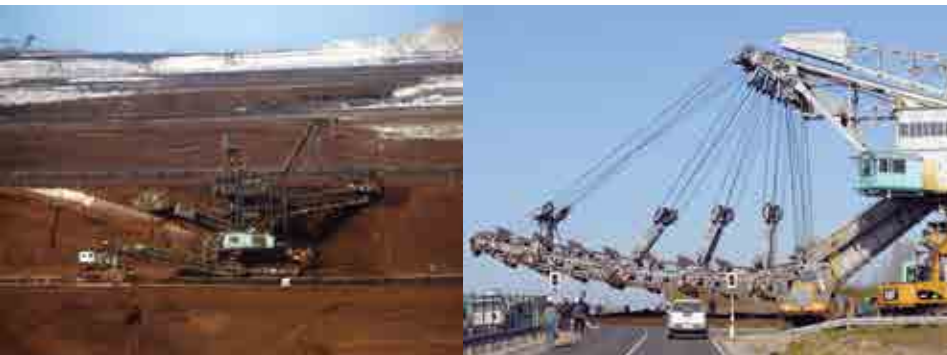
Montage des Schaufelradbaggers 1580 im Tagebau Profen, 1995
