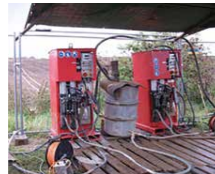
Injektionsanlage für Schachtverwahrungsarbeiten an der Tiefbaugrube Wilhelm und Nr. 522 bei Theißen, 2012 Kontrollfahrt auf dem Restloch Vollert-Süd, 2004
