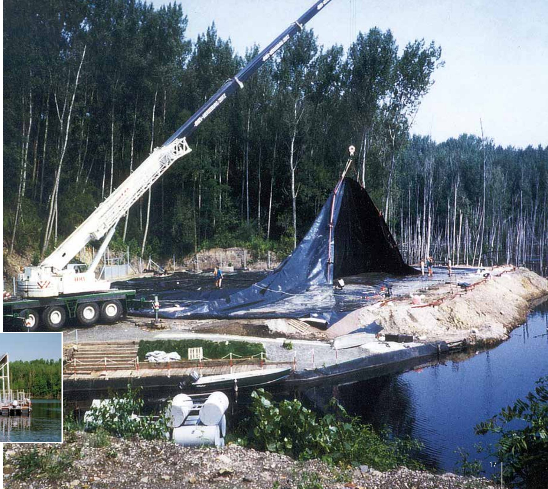
Vorbereitung eines Enclosures am Restsee Vollert-Süd, 1997
