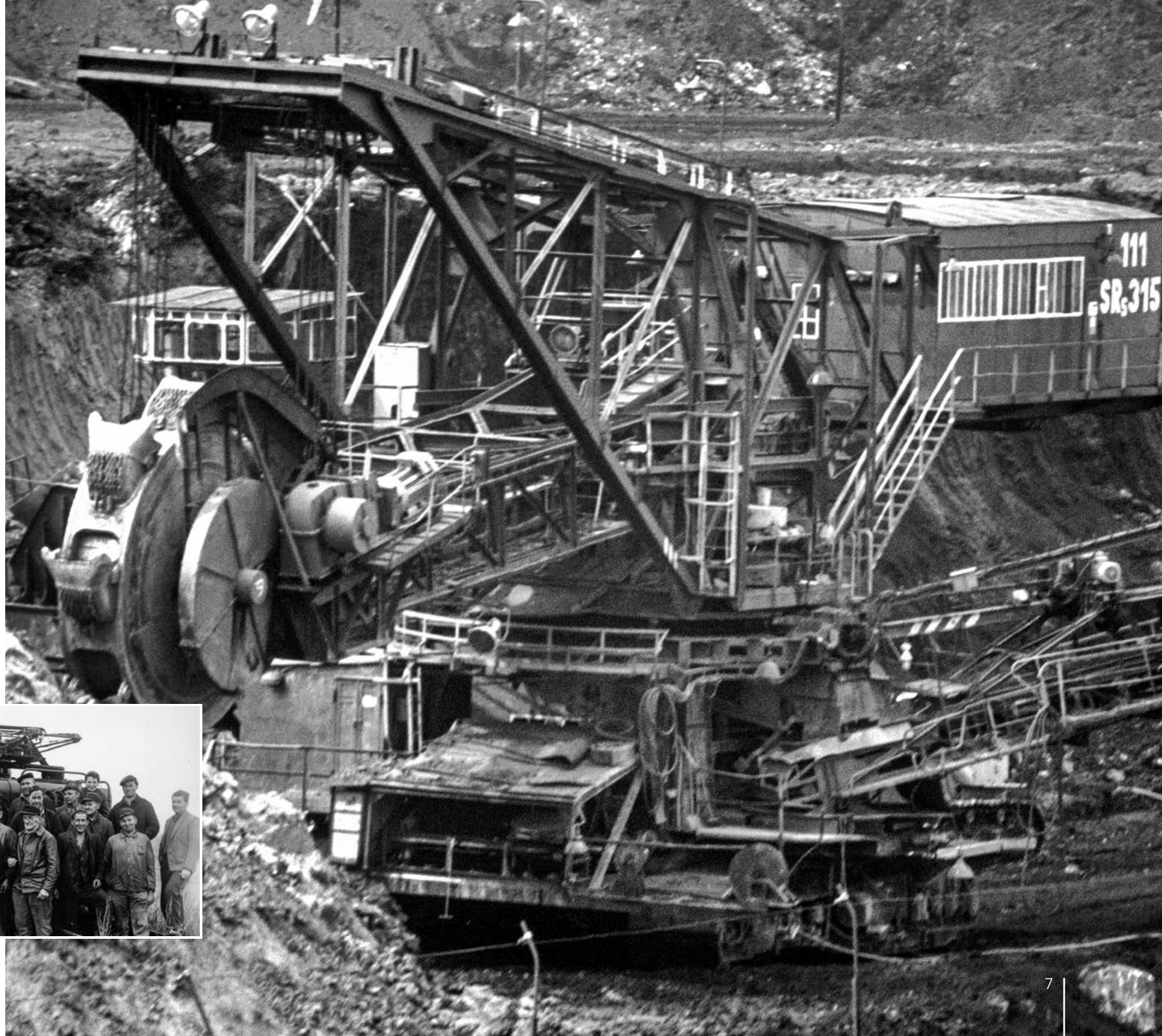
Bagger SRs 315a-111 im Auslaufbetrieb im Tagebau Olbersdorf, 1990
