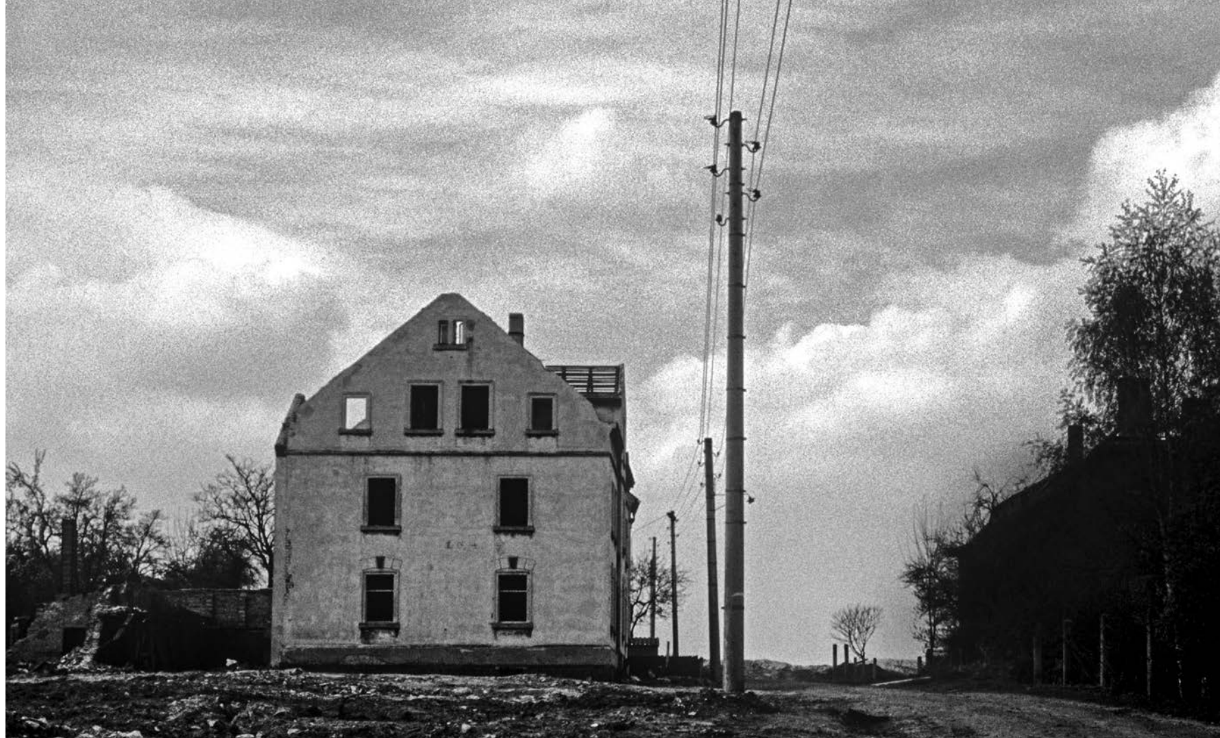
Häuser an der Seibtstraße in der Ortslage Olbersdorf kurz vor dem Abbruch, 1990
