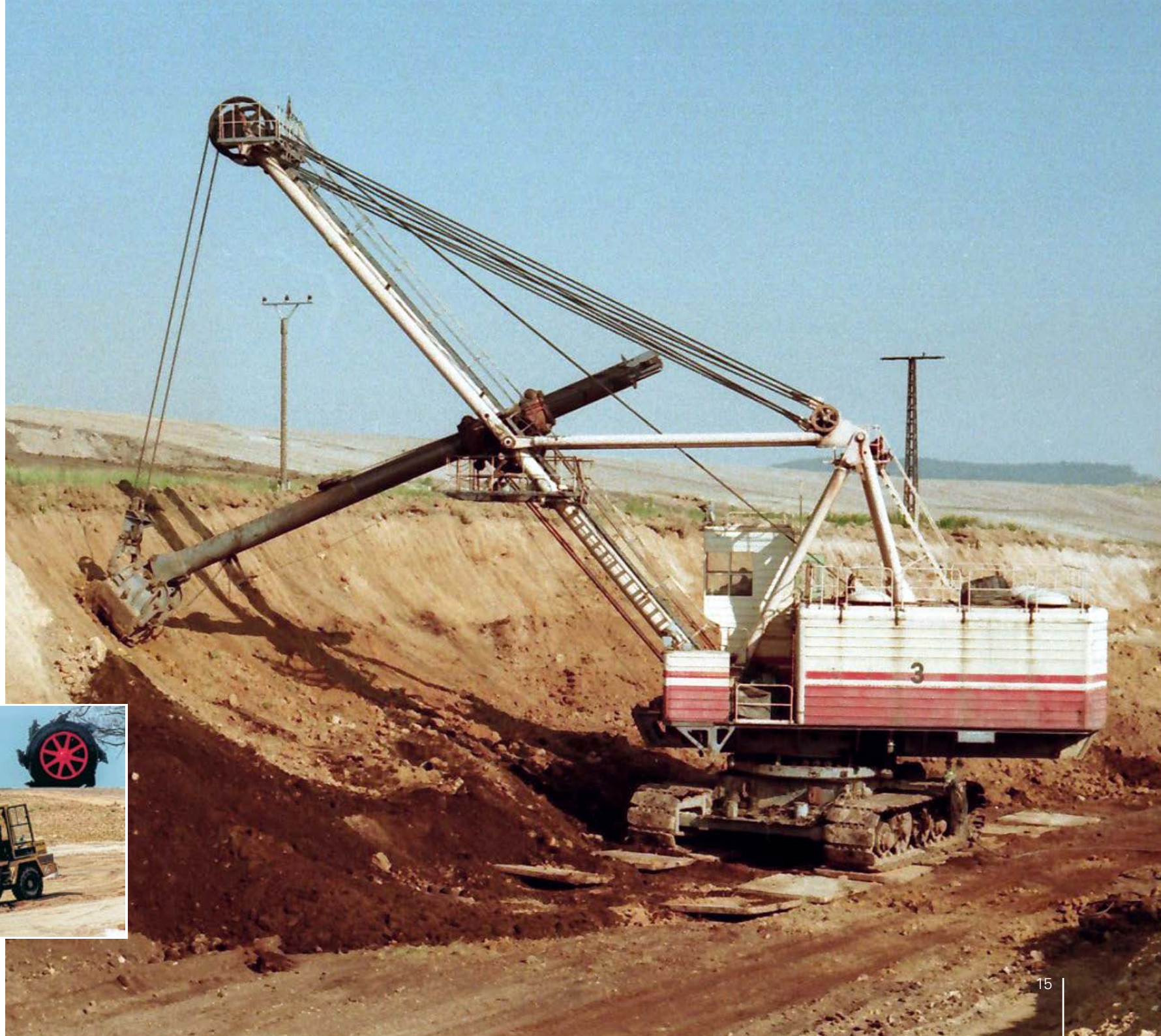
Löffelbagger bei der Massen- umsetzung im Sanierungstagebau Olbersdorf, 1996
