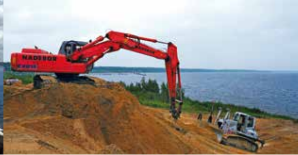
Steganlage Bärwalder See, 2009
