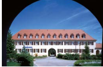
Saniertes Gebäude in der Gartenstadt Lauta-Nord, 2007
