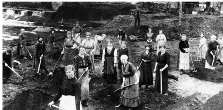
Putzkolonne beim „Nachputzen“ – manuelle Säuberung der Flözoberfläche von Abraumresten, 1925 „Weiße Brücke“ des Braunkohlenwerkes „John Scheer“, 1954
