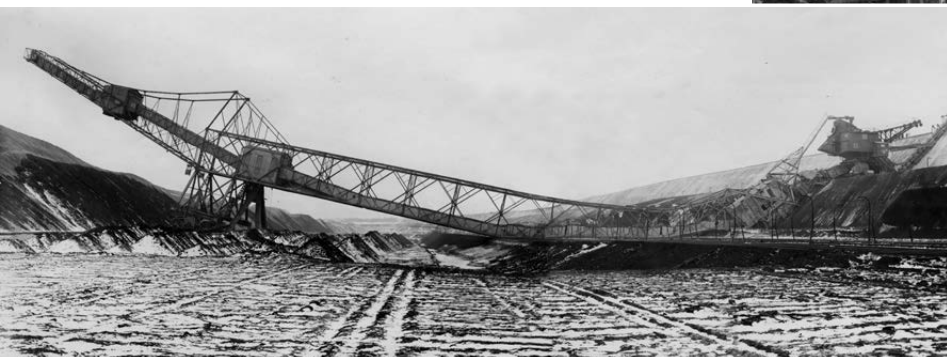
Eingestürzte Abraumförderbrücke im Tagebau Erika, 1937
