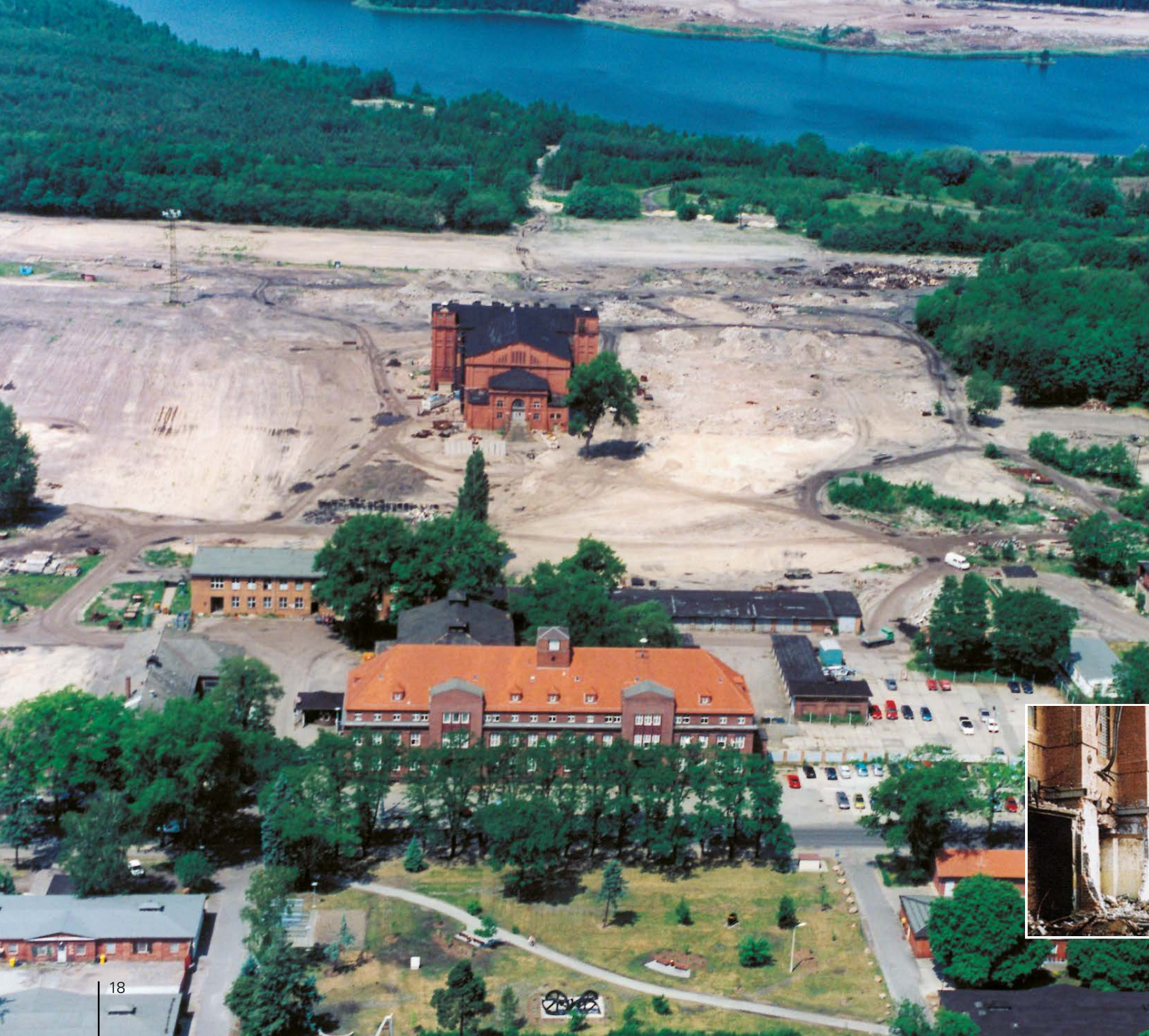
Fläche des ehemaligen Veredlungsstandortes Laubusch mit Verwaltung und Turbinenhaus nach einer weitgehenden Beräumung, 1997
