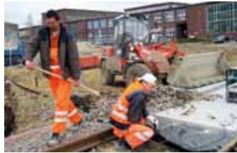
Baumaßnahmen im entstehenden Industriepark Espenhain, 2004
