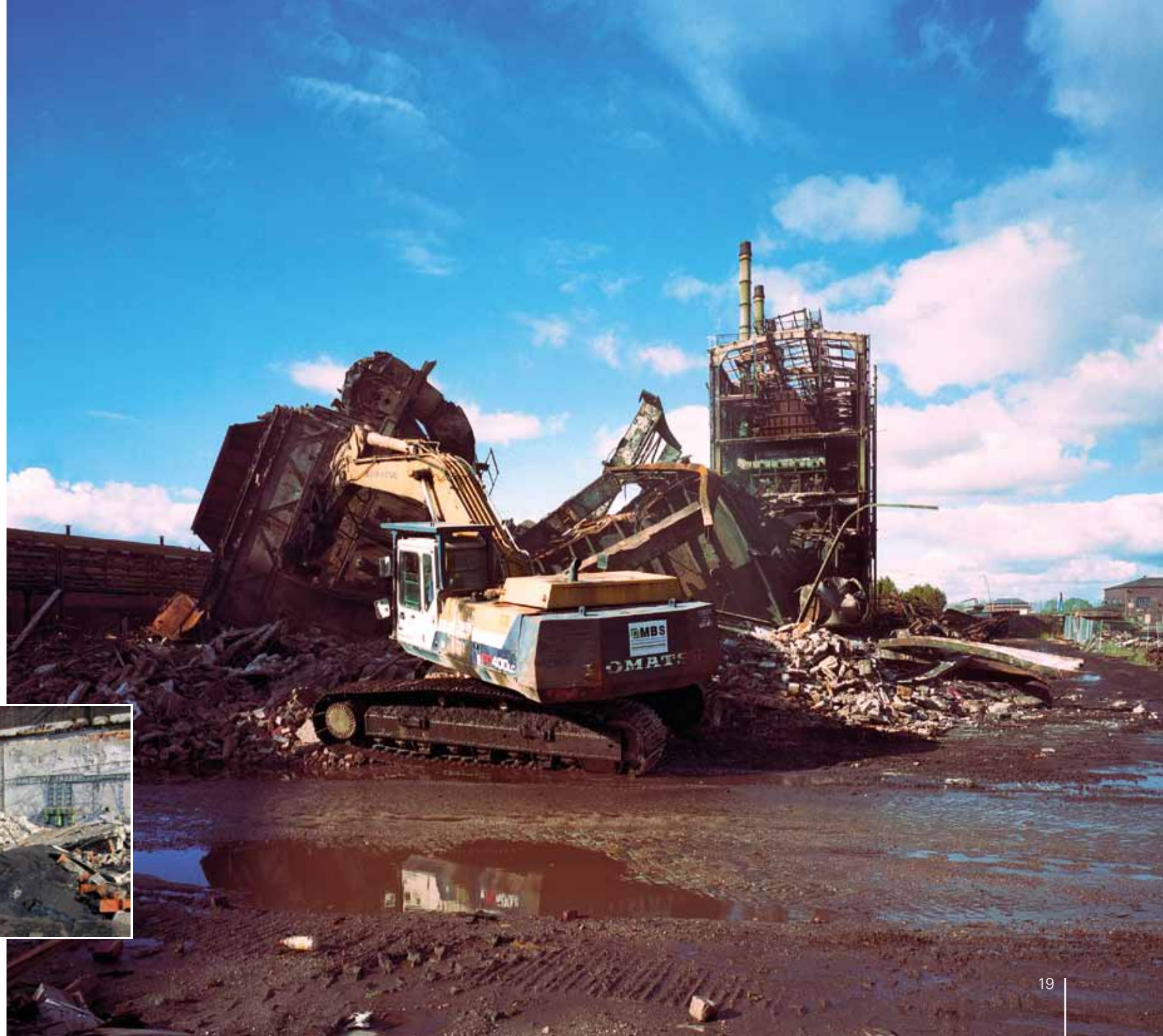
Abbrucharbeiten an der Schwelerei II am Veredlungsstandort Espenhain, 1997
