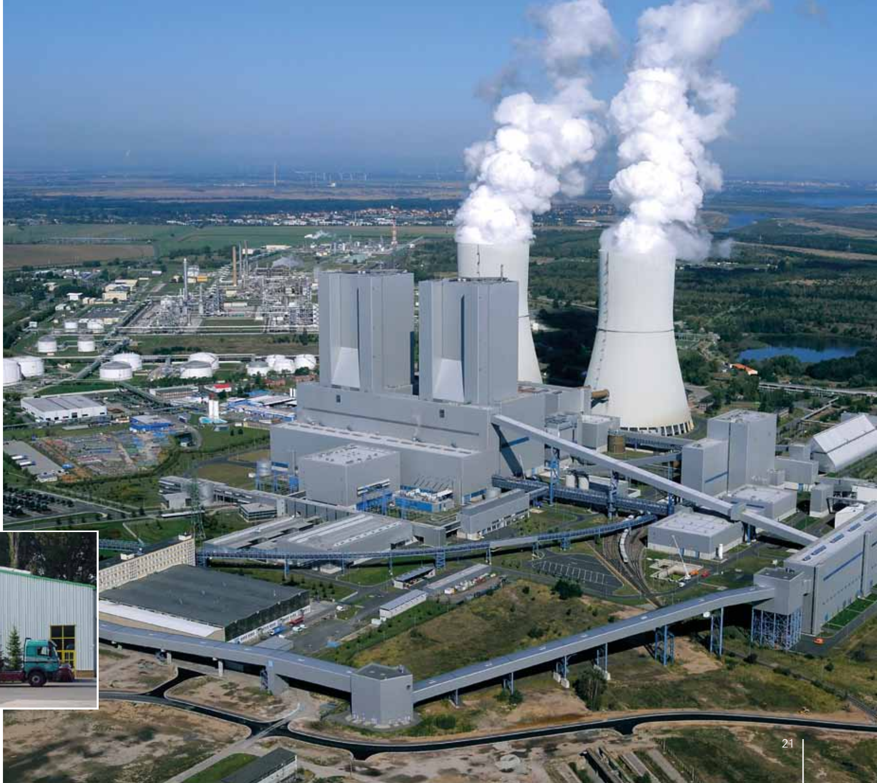
Neubaukraftwerk Lippendorf aus der Luft, 2008
