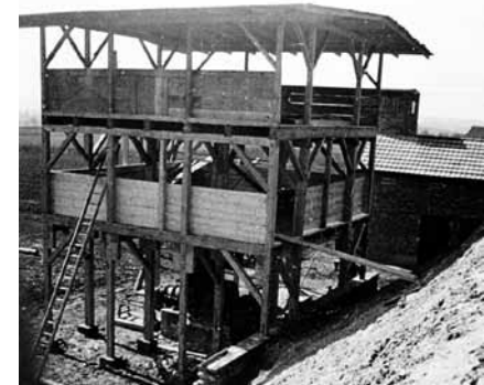
Nasspresse in der Grube Bocka, altes Verfahren als Notlösung in der Nachkriegszeit, um 1950 Formleger in der Brikettfabrik Deutzen bei Borna, um 1963
