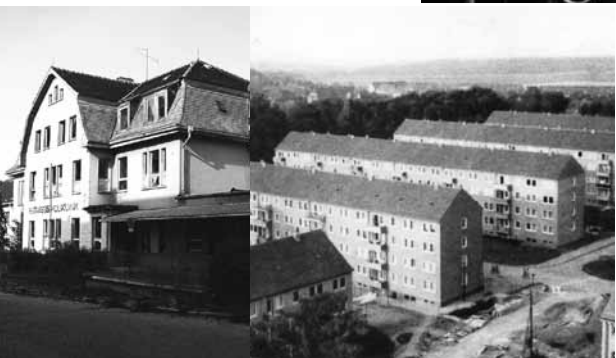
Leerstehende Betriebspoliklinik Deuben, 2000 Neubausiedlung in Böhlen, um 1975
