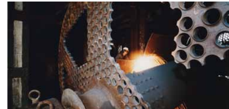
Rückbau der Röhrentrockner in der Brikettfabrik Regis-Breitungen, 1996 Abriss des Trockenhauses der stillgelegten Brikettfabrik Regis, 1997
