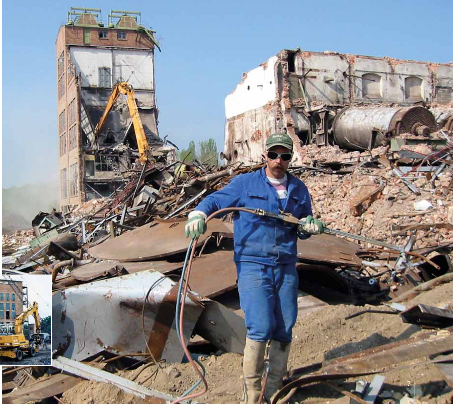
Abriss der Brikettfabrik Zechau, 2004
