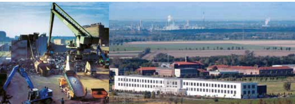
Dienstleister im Industriepark Espenhain, 2005 Scholz Recycling am Standort Espenhain, 2000 Schaltwarte Espenhain nach dem Umbau, 2011
