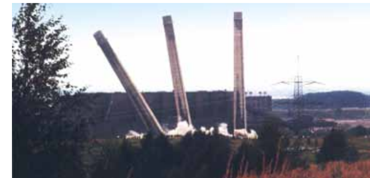
Sprengung der drei Schornsteine des Kraftwerks II Espenhain, 1999 Abbrucharbeiten auf dem Veredlungsstandort Espenhain, 2003
