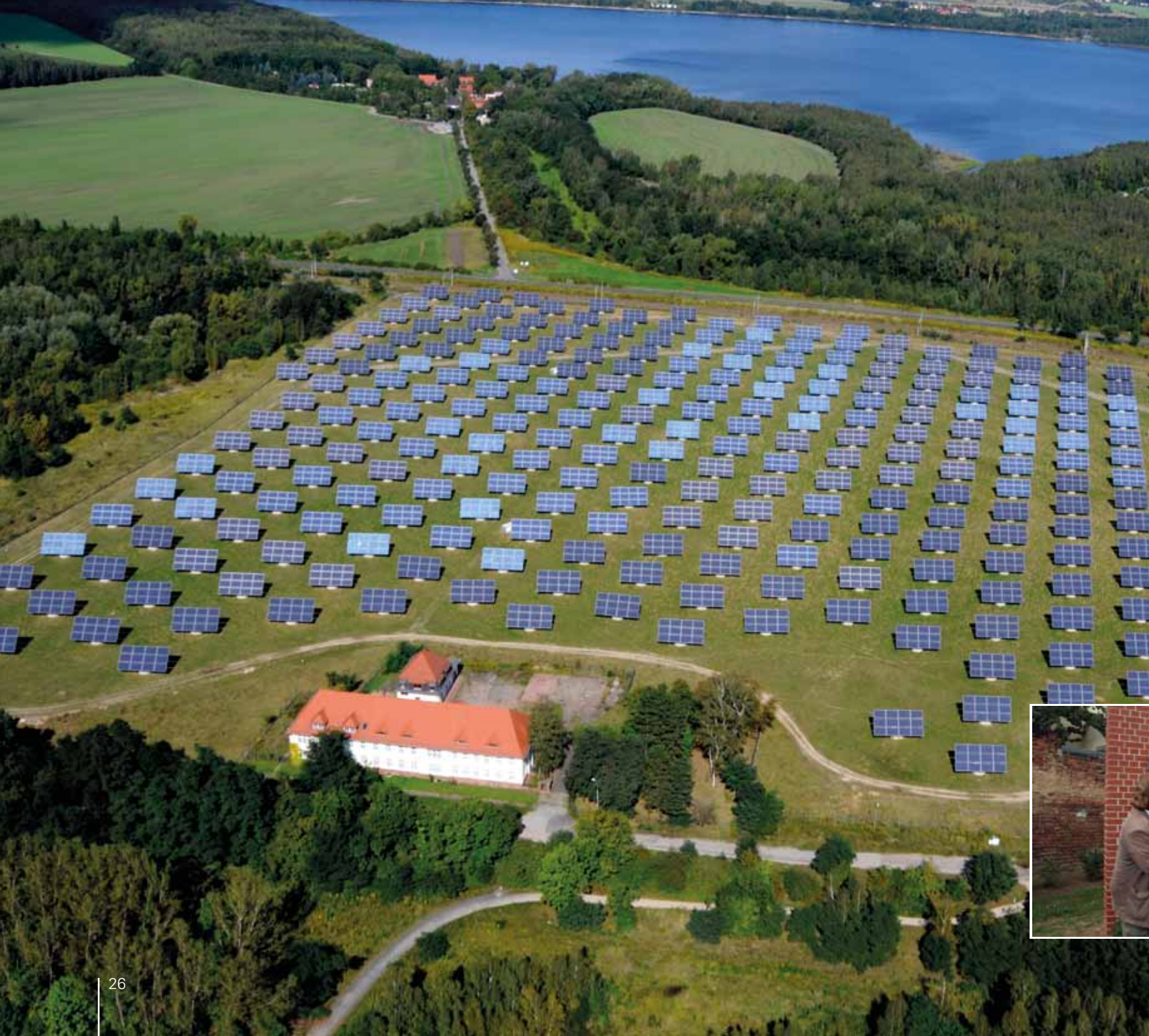
Solkraftwerk Borna mit Speicherbecken Witznitz im Hintergrund, 2008
