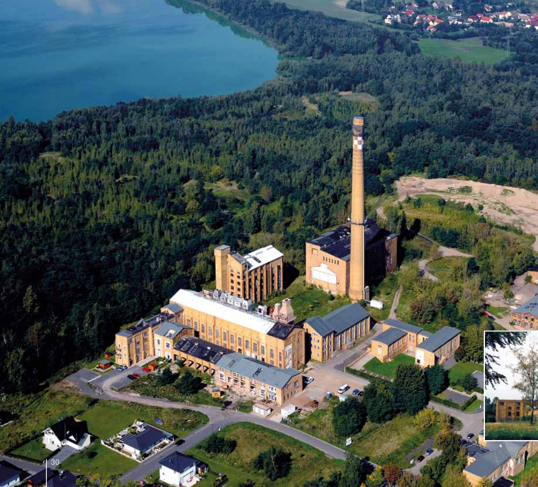
Als Landmarke erhaltene und in Teilen nachgenutzte Brikettfabrik Witznitz, 2010
