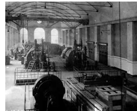
Turbinensaal der Kraftzentrale des Braunkohlenwerkes Deutzen, 1928 MAN-Turbinen im Kraftwerk Deutzen, um 1960
