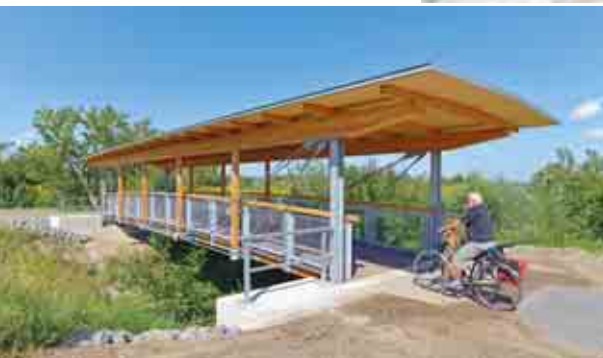
Neue Brücke über den „Gösel-Canyon“ am Störnthaler See, 2017
