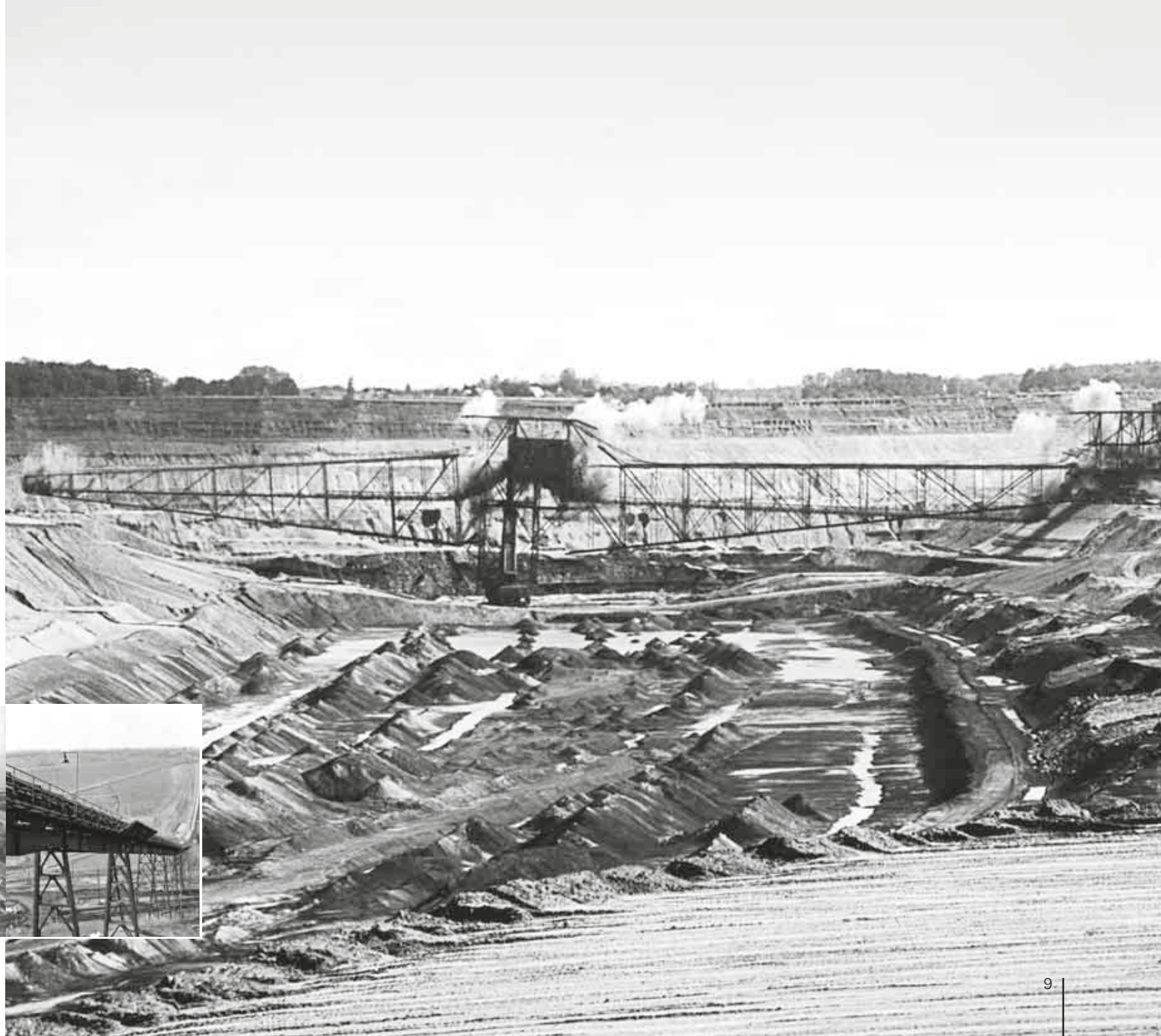
Sprengung der Abraumförderbrücke AFB 17 im Tagebau Espenhain, 1997
