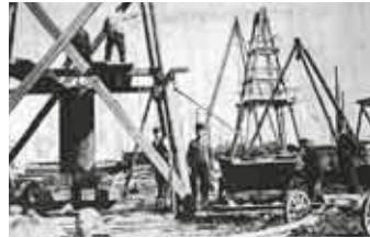
Herstellung des Fluchtschachtes für den Tagebau Espenhain, 1938
