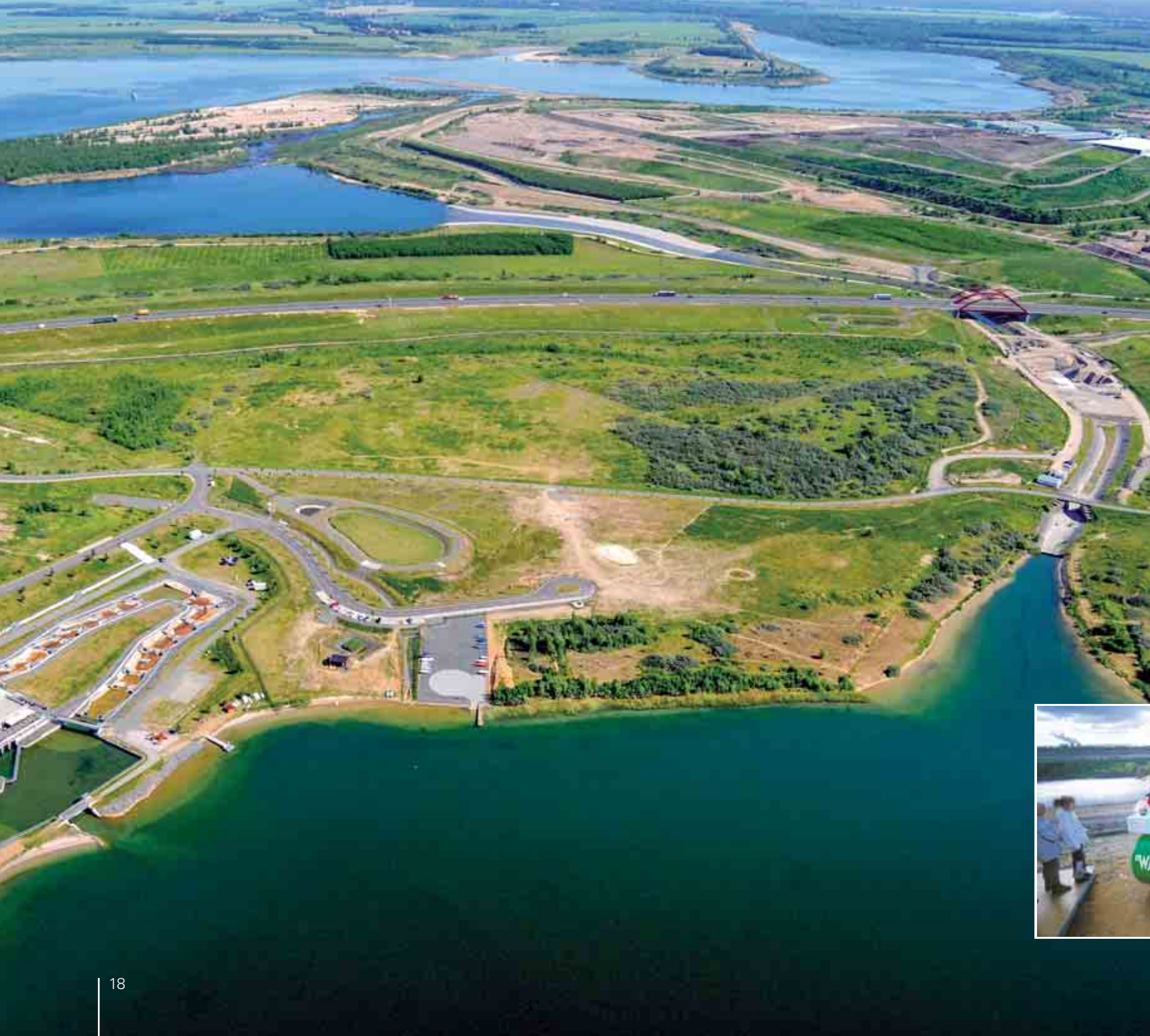
Überleiter mit Kanuparkschleuse (im Bau) zwischen Markleeberger See (vorn) und Störmthaler See, 2011
