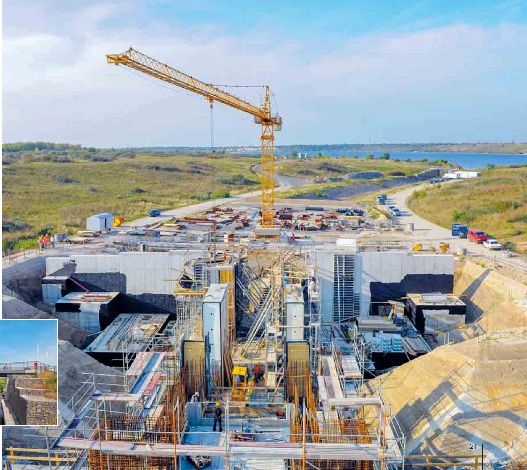
Bau der Kanuparkschleuse, 2011
