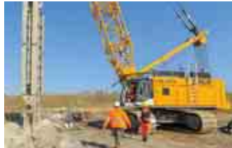
Bau einer unterirdischen Dichtwand zwischen Markleeberger See und Störmthaler See, 2011
