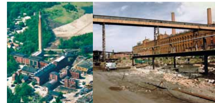
Beräumte Fläche der ehemaligen Brikettfabrik Zeißholz, 2006
