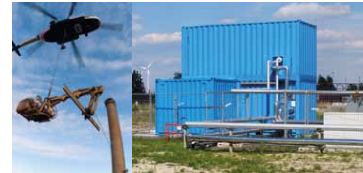
Sprengung des Kesselhauses des Kraftwerks Mitte, Schwarze Pumpe, 2000
