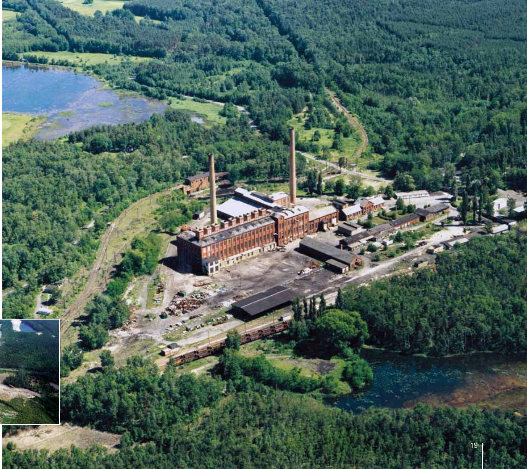
Brikettfabrik Zeißholz in der Abbruchphase, 1995
