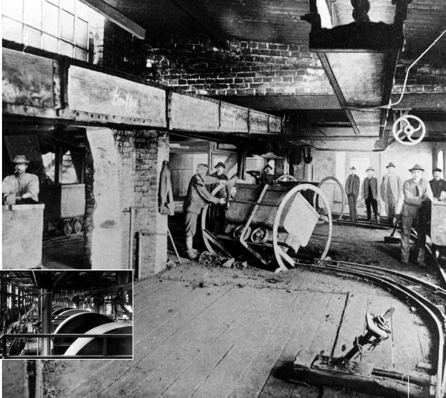
Kreisel-Wipperanlage der Kohlenverteilerstelle in einer Lausitzer Brikketfabrik, um 1910
