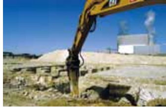
Abbrucharbeiten in Schwarze Pumpe, 2003
