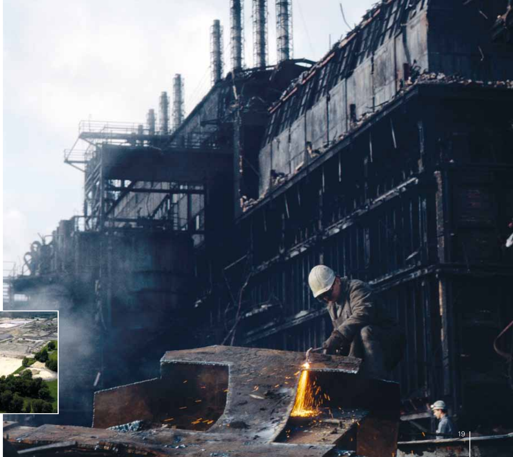
Abrissarbeiten in der Kokerei Lauchhammer, 1994
