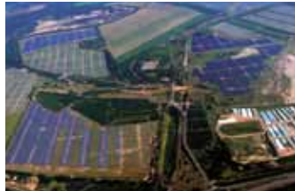
Solarkraftwerk im ehemaligen Tagebau Meuro, 2011
