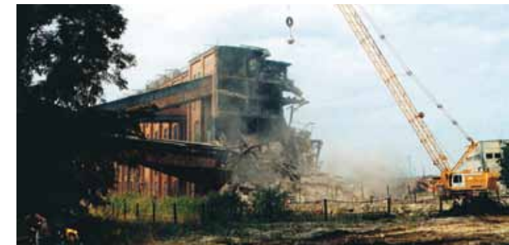
Ehemaliges Kokereigelände in Lauchhammer während der Sanierung, 2003
