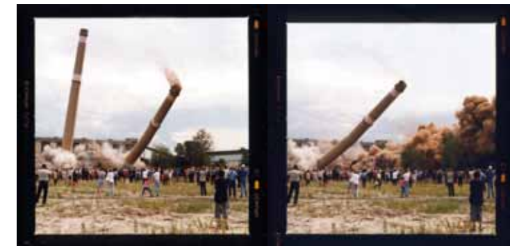
Sprengung der 140-Meter-Schornsteine des Industrie-Kraftwerks Brieske, 2000 Teilweise abgerissene Brikettfabrik 69 in Lauchhammer, 1995
