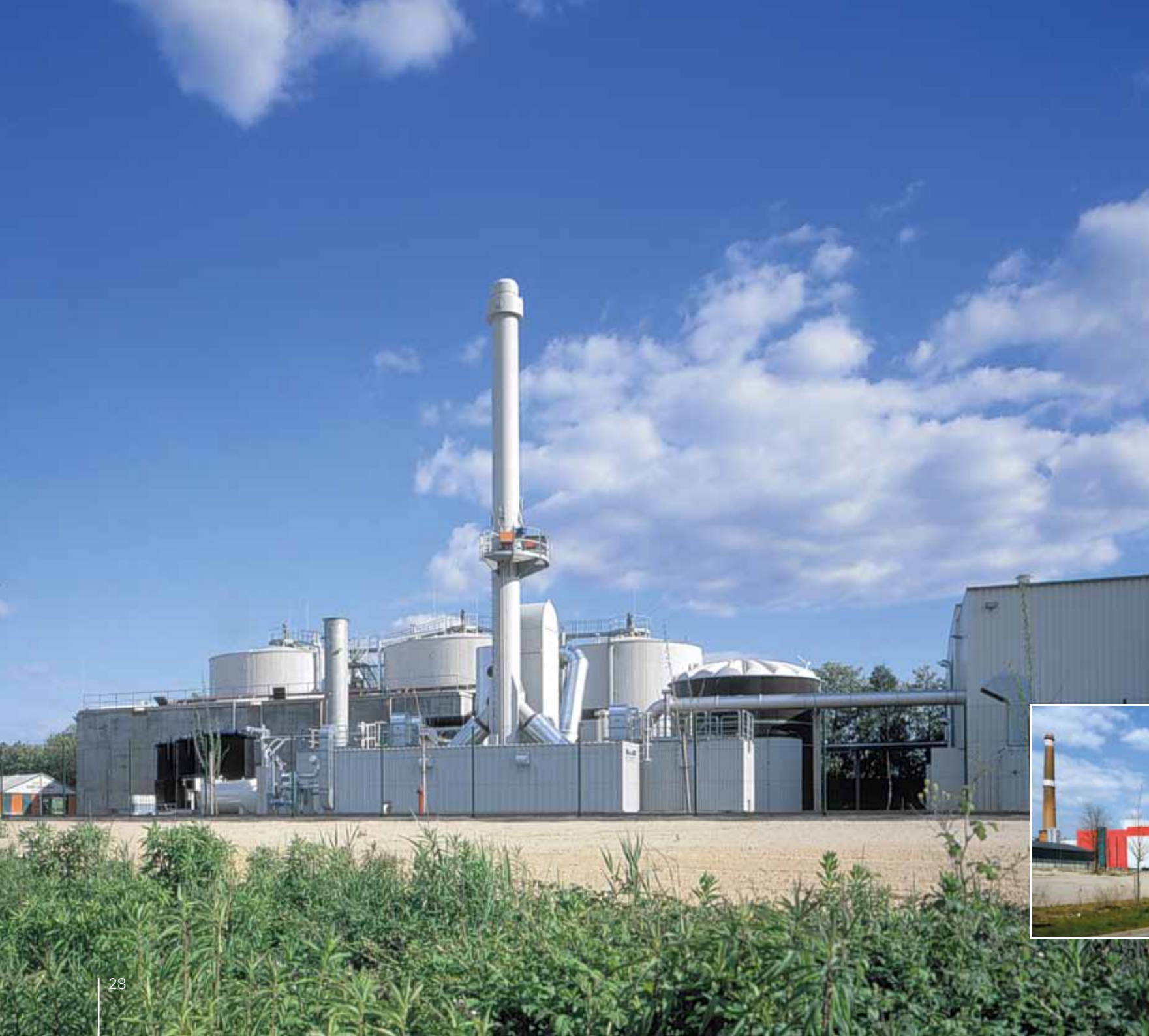
Biogasanlage im Industriepark Marga/ Senftenberg, 2007
