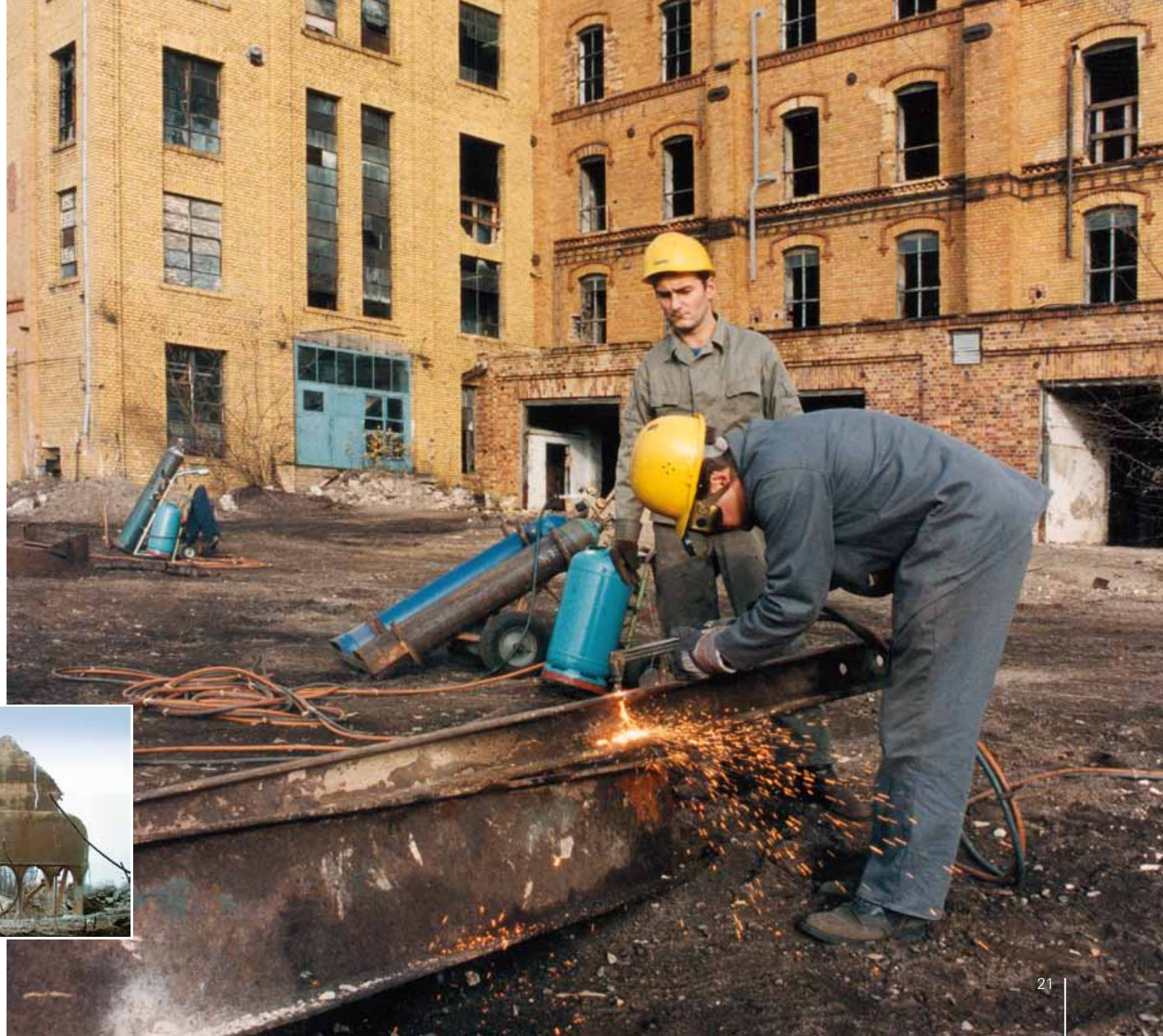
Demontagarbeiten an der Brikettfabrik 66 in Lauchhammer, 1994
